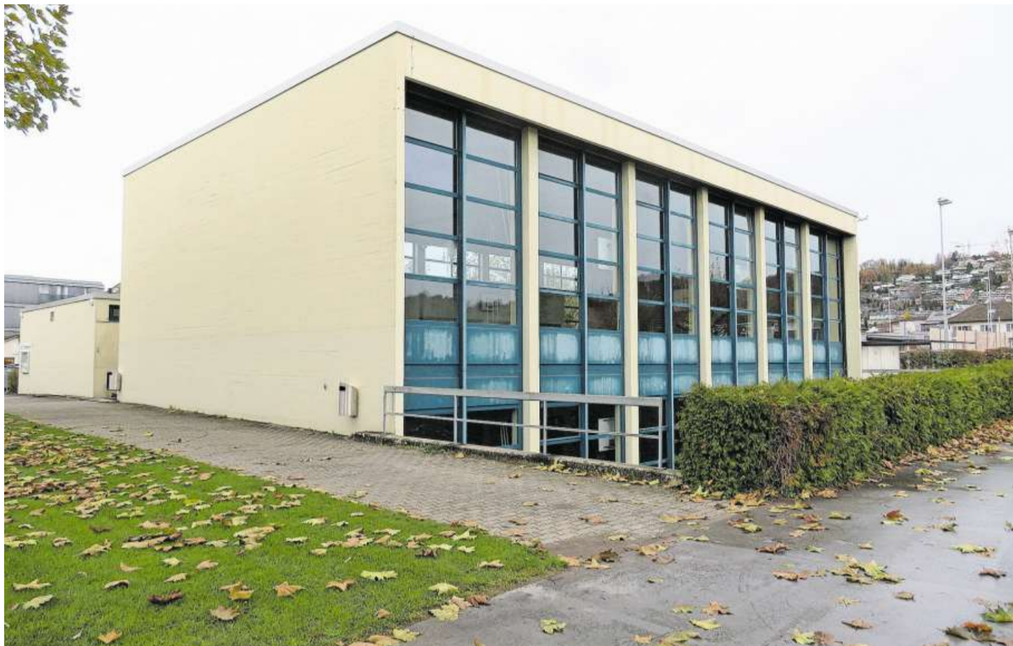
Die alte Doppelhalle Bärenmatte stammt aus den 1960er-Jahren und entspricht nicht mehr den Anforderungen.
